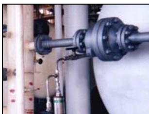
2" MKII Fliehkraftabscheider
